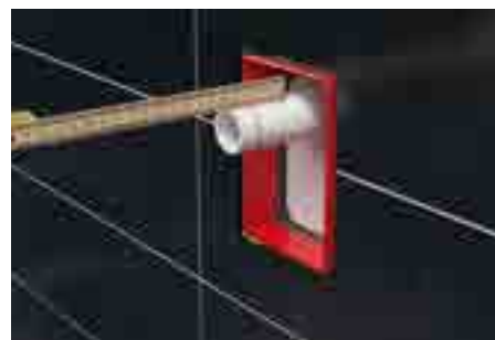
6. Щуцера с резбата се маркира на 3 см от готовата стена (плочките).
